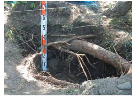
大径木の根の状況
